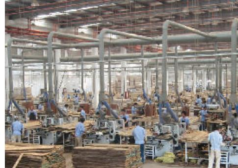
Unutrašnji razvod izvodimo cijevima elemenata svih potrebnih oblika i dimenzija od pocijančanog i dekapiranog lima. Sastave izvodimo zavarivanjem duplim previjanjem.
