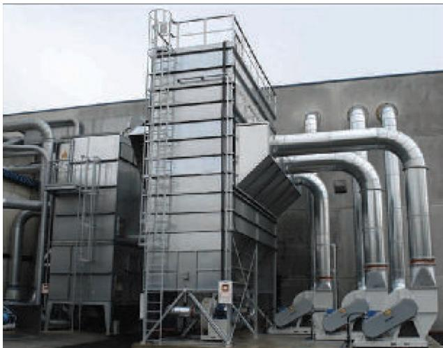
Ventilatore izvodimo u oblicima: SMK, SMM, NGM i MK i primjenjujemo ih za sve uslove i vrste odsisanja, otpolinjavaju i transporta. Imaju mogućnost široke primjene od vrlo malih kapaciteta (do 5.000 m<sup>3</sup>/h), do kapaciteta od 140.000 m<sup>3</sup>/h. Izrađujemo ih u normalnj i ojačanoj izvedbi sa antivibracionim elementima radi spriječavanja prenošenja vibracija. Imaju visok stepen učinka i mogućnost postavljanja u serijsku vezu.
